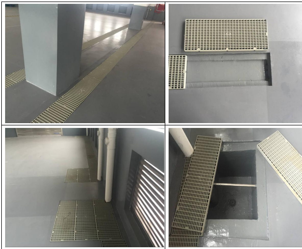
地坪和墙裙须作防渗、防腐处理
