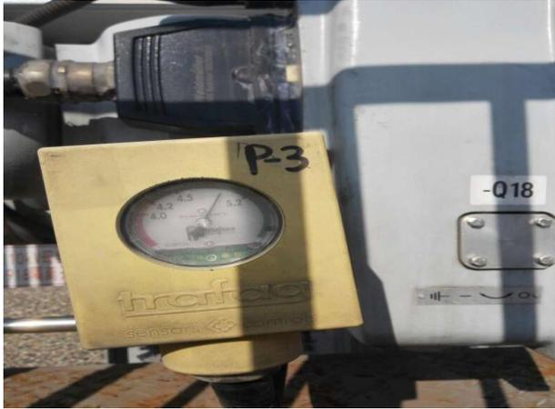
变电站 SF<sub>6</sub> 探测报警仪
