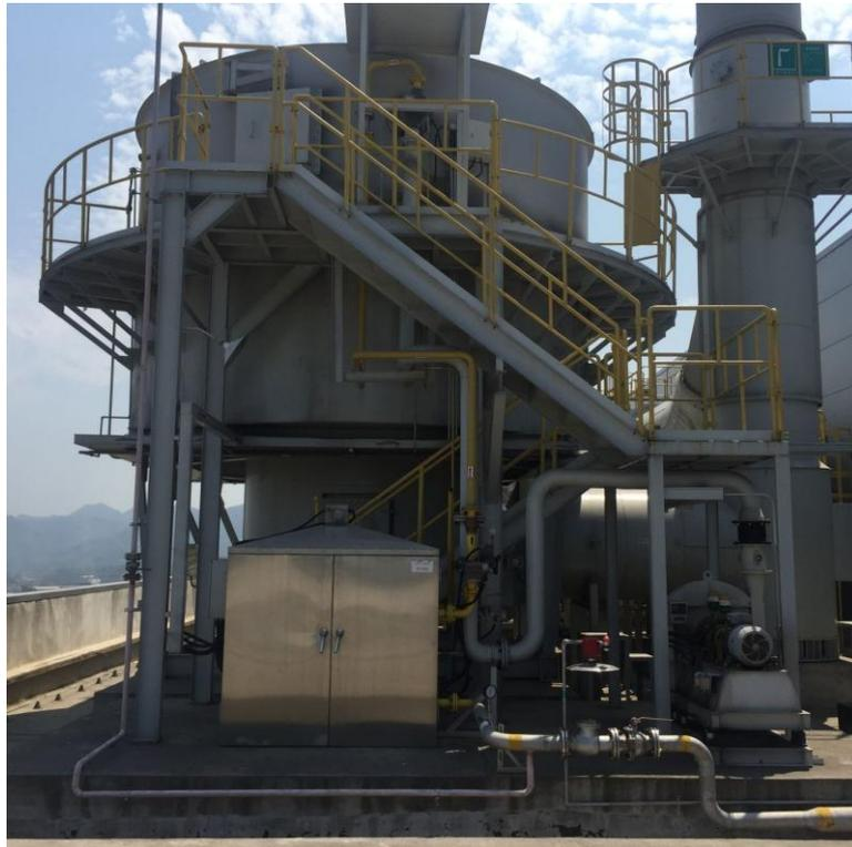
图 4-7 喷涂及烘干废气处理设施设置情况图
