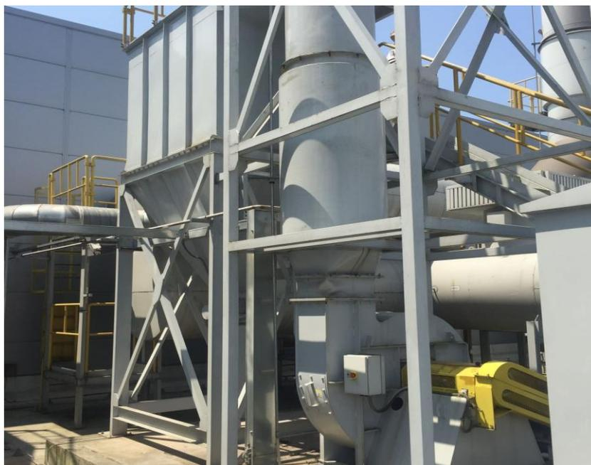
图 4-5 修边、破碎废气处理设施设置情况图
