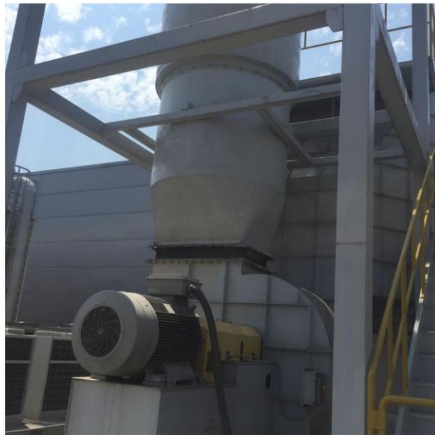
图 4-3 注塑废气处理设施设置情况图
