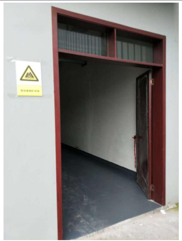
危险废物存放间
