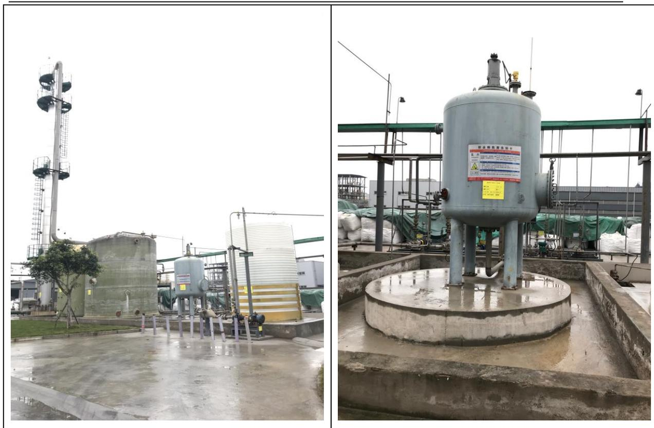
图 4.4 汽提脱氨装置设置情况图
