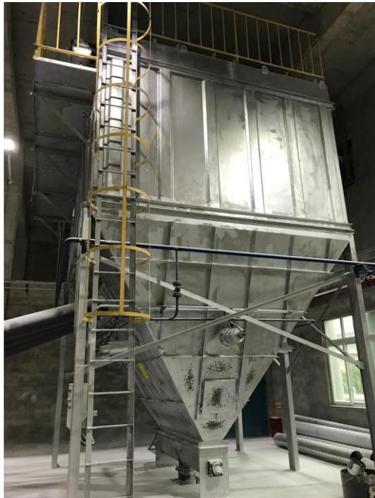
图 4.10 钛酸锂用钛白粉粉碎废气处理设施设置情况图
