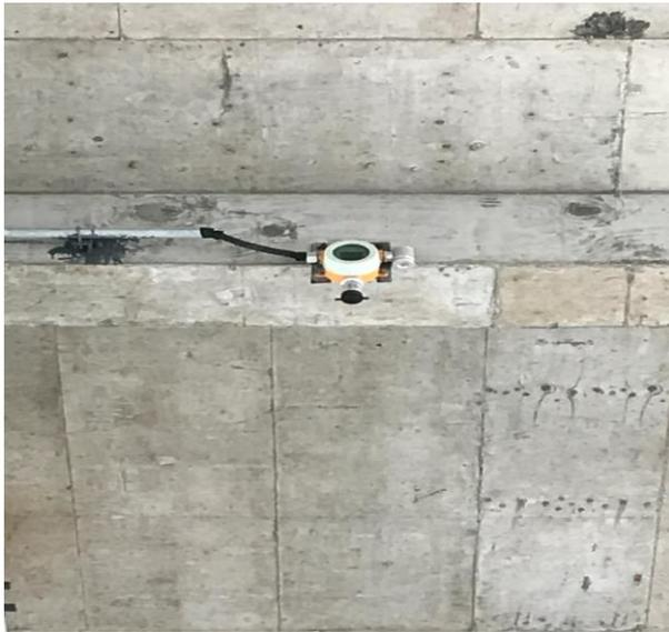
C-801 钛白粉压滤工序设氨气泄漏报警装置
