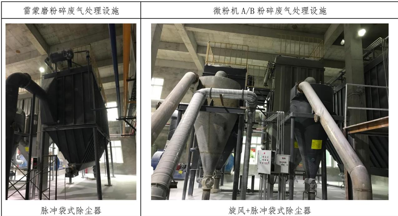
图 4.8 C-801 钛白粉粉碎废气处理设施设置情况图
