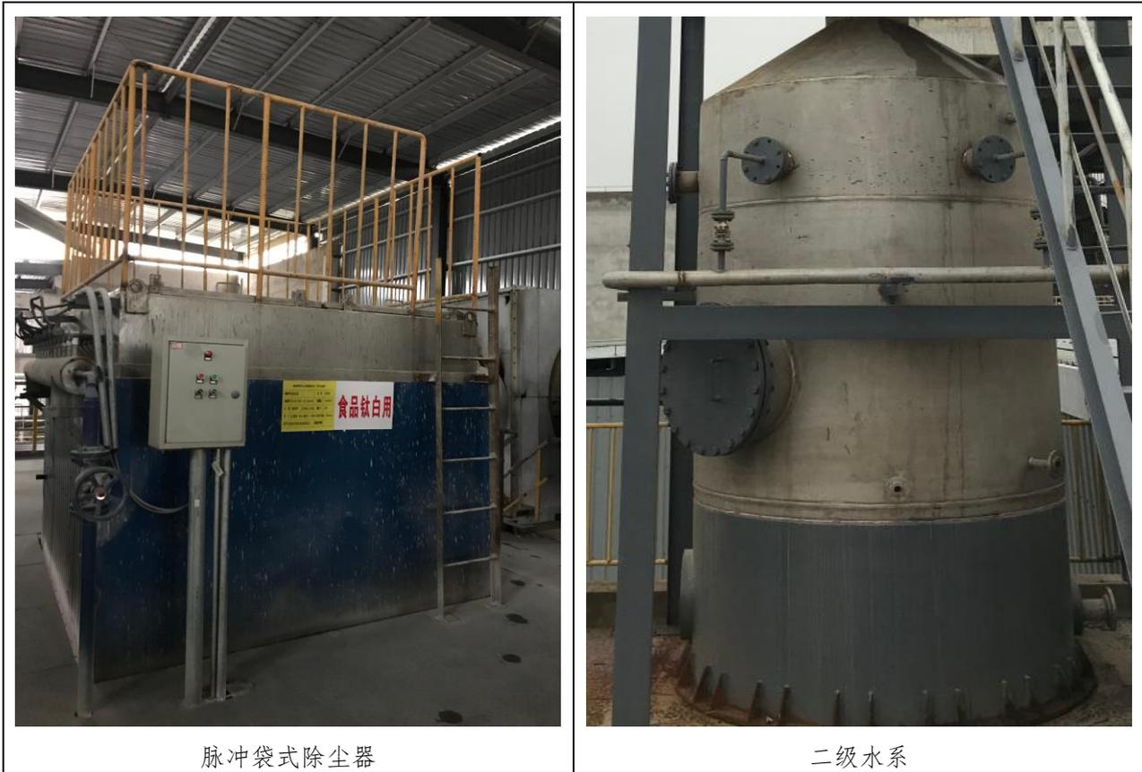
图 4.6 煅烧废气处理设施设置情况图
