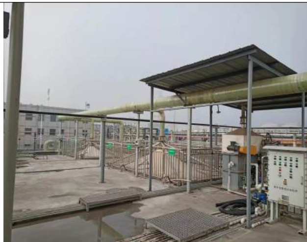
污水处理站废气收集设施
