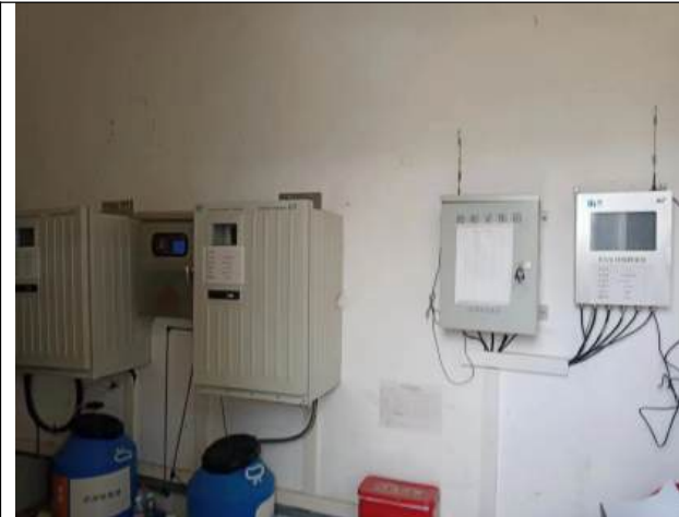
废水在线监测仪安装情况
