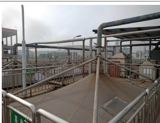
污水处理站废气收集设施
