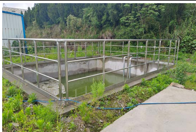
项目片区事故废水收集池（120m 3 ）
