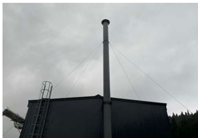
排气筒设置情况
