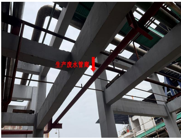
废水管道设管廊架送污水处理站
