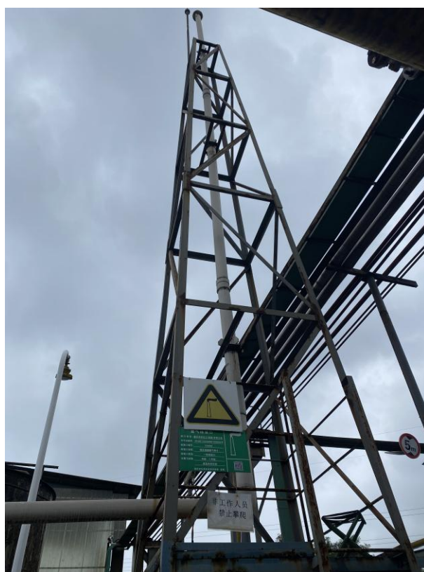
储罐呼吸废气排放口（依托）
