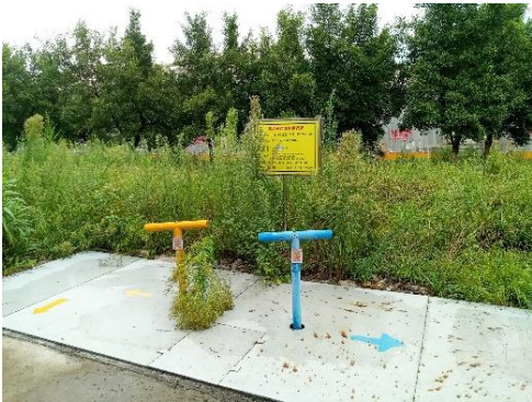
装置区雨污分流阀
