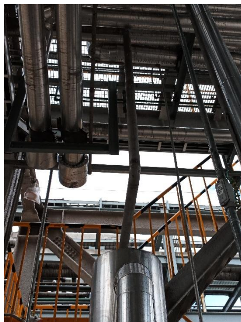
V 膜真空废气管道
