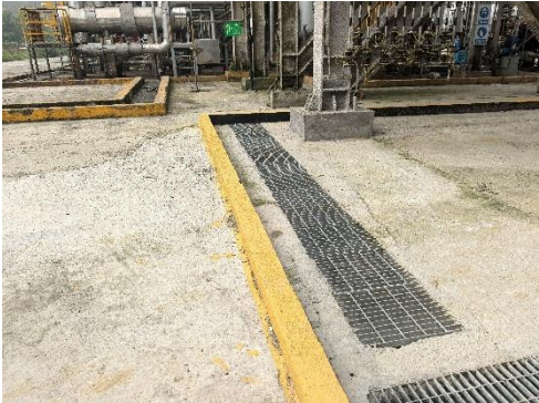
装置围堰、收集沟
